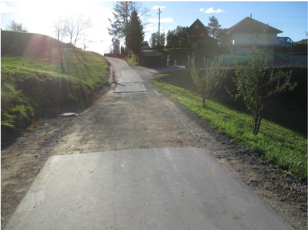
slika plazovitega območja in poškodb na asfaltni cesti (v nasprotni smeri stacionaže)
